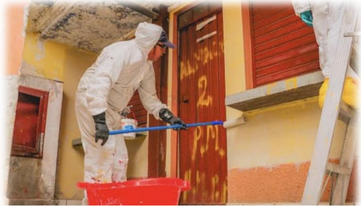
REFACCIÓN DEL MERCADO BARATILLO
