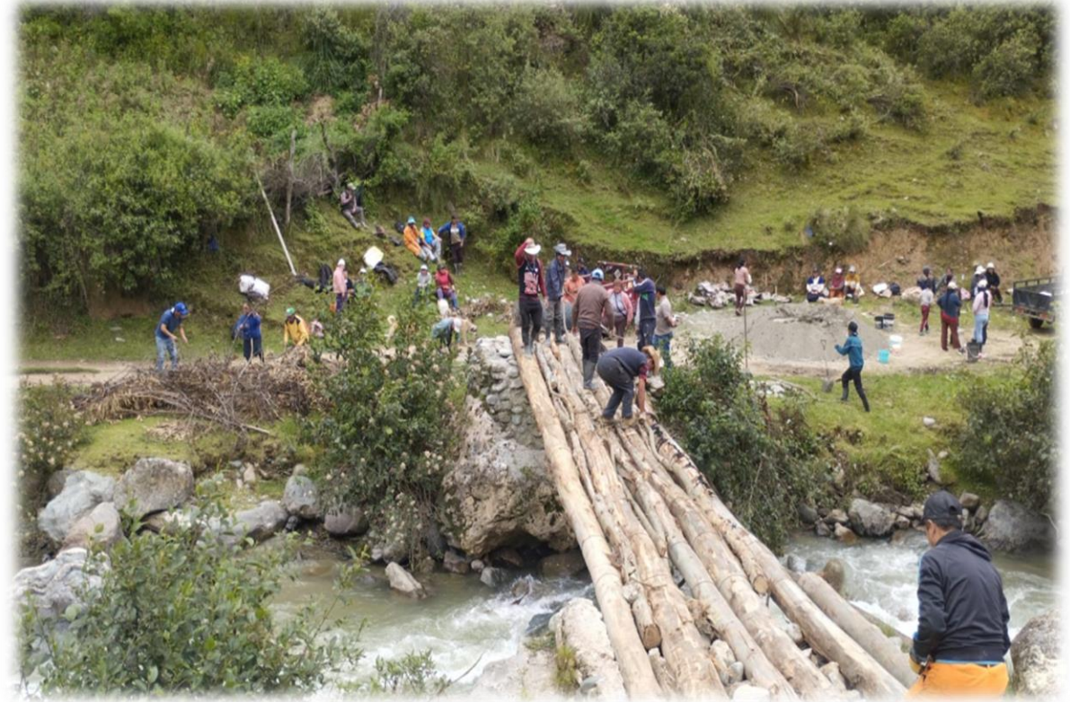
CONSTRUCCIÓN DE PUENTE CHINCHAN - HUARIACA
